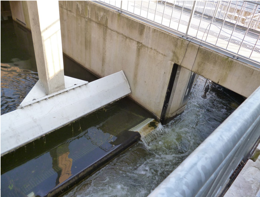
Bild 6: Oberflächen-Bypass und Übergang zur Geschwemmselrinne
