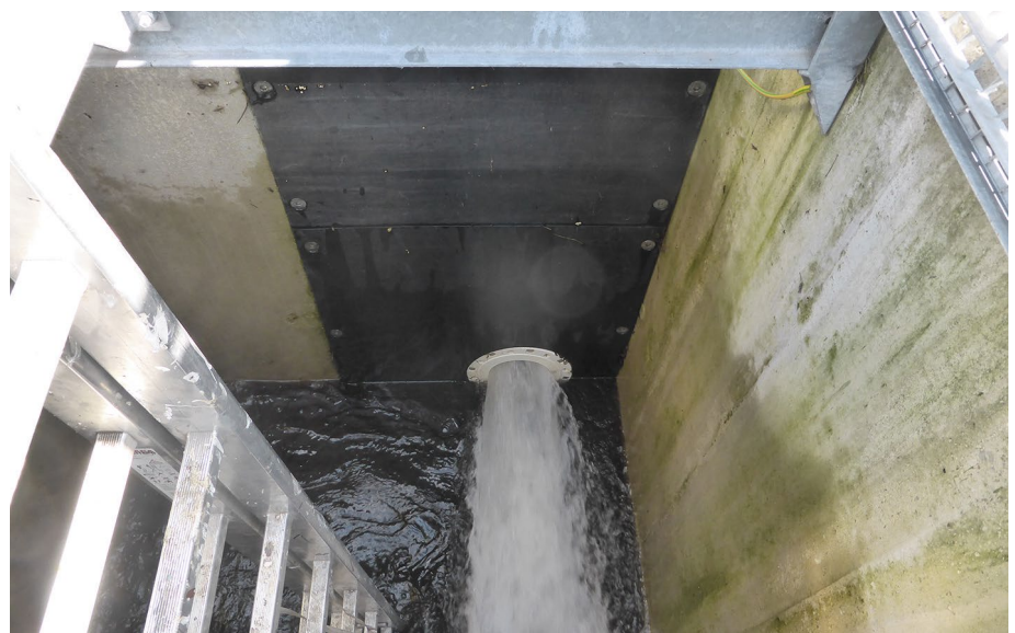
Bild 3: Aalfangkammer mit Zulauf aus der Bottom Gallery
